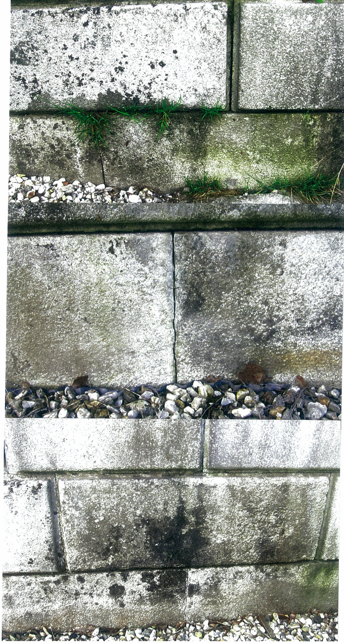
DETAILY ABSENCE SPÁROVÁNÍ, PRORŮSTÁNÍ NÁLETŮ, ČERNOTY NA POVRCHU
