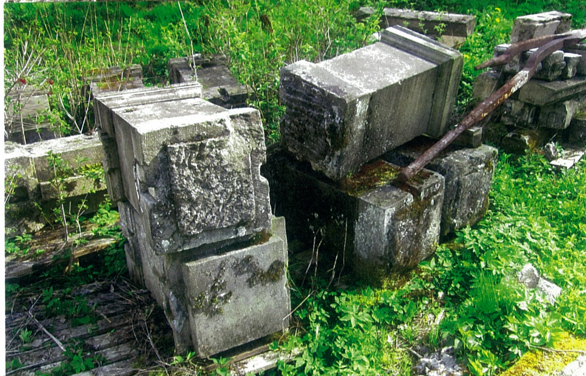
DETAIL POŠKOZENÍ PROFILACE TRNOŽE BALUSTRU, DOLE FOTO PÍSKOVCOVÝCH, PŮVODNÍCH PILÍŘŮ U HROBKY
