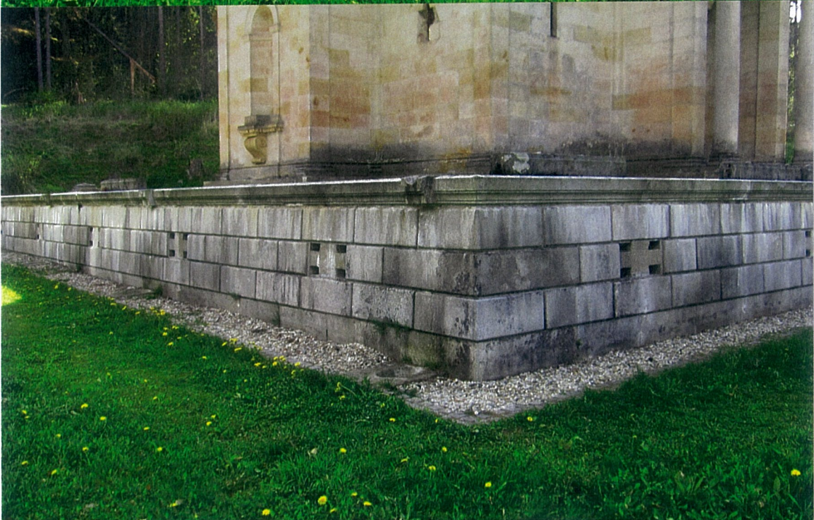
POHLEDY NA SOKLOVOU ARCHITEKTURU TERASY ZE SLEZSKÉ ŽULY ZAKONČENOU PROFILOVANOU ŘÍMSOU
