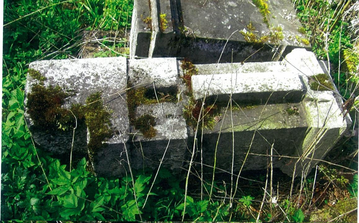
MECHANICKY POŠKOZENÉ PROFILACE, USAZENÉ NEČISTOTY A BIONÁLETY NA POVRCHU. DOLE FOTO ŽULOVÉ PILÍŘE VSTUPNÍHO SCHODIŠTĚ
