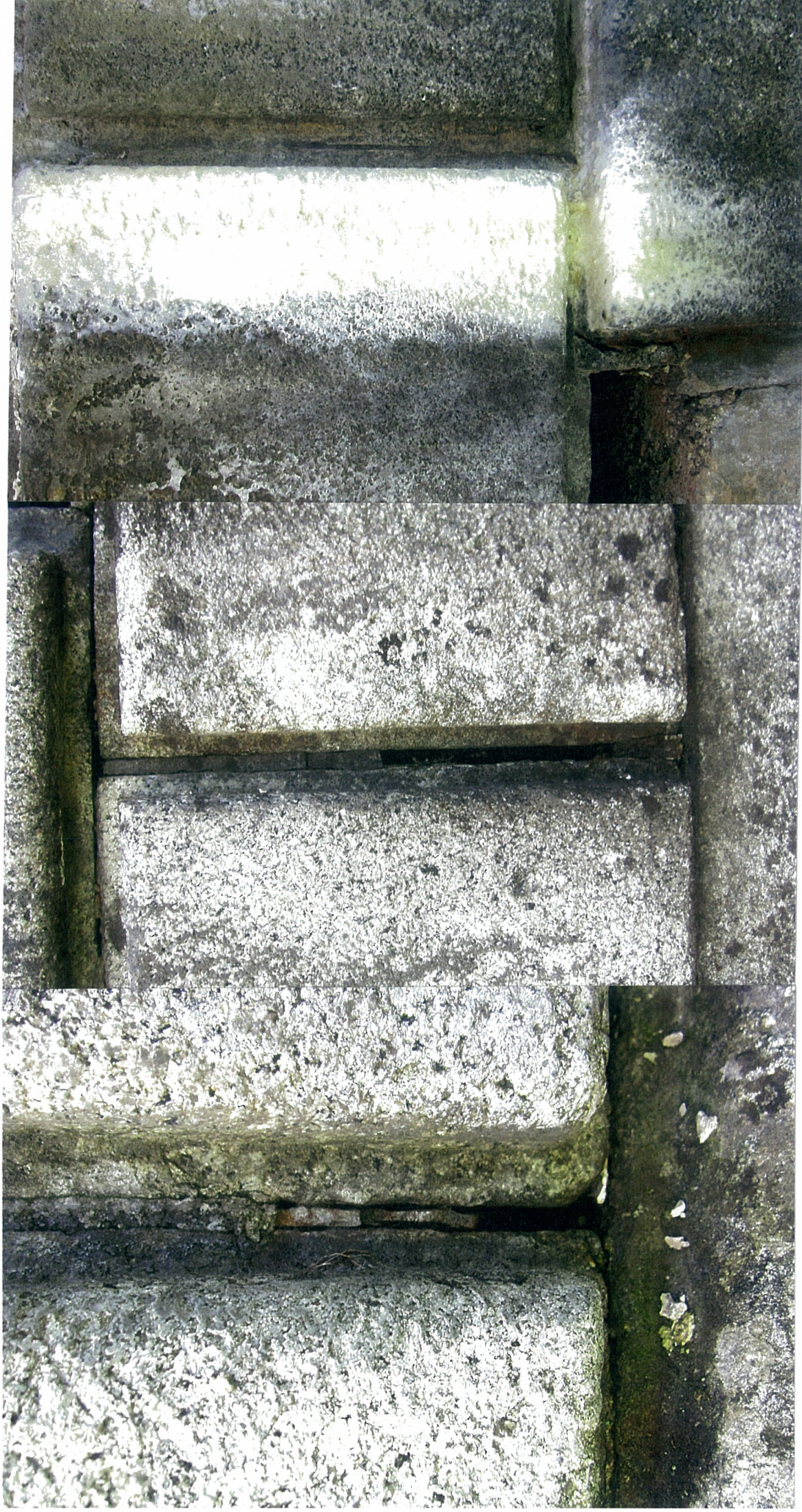
DETAILY VYDROLENÉHO SPÁROVÁNÍ, VPRAVO FOTO ZVÁPENATĚLÁ KRUSTA
