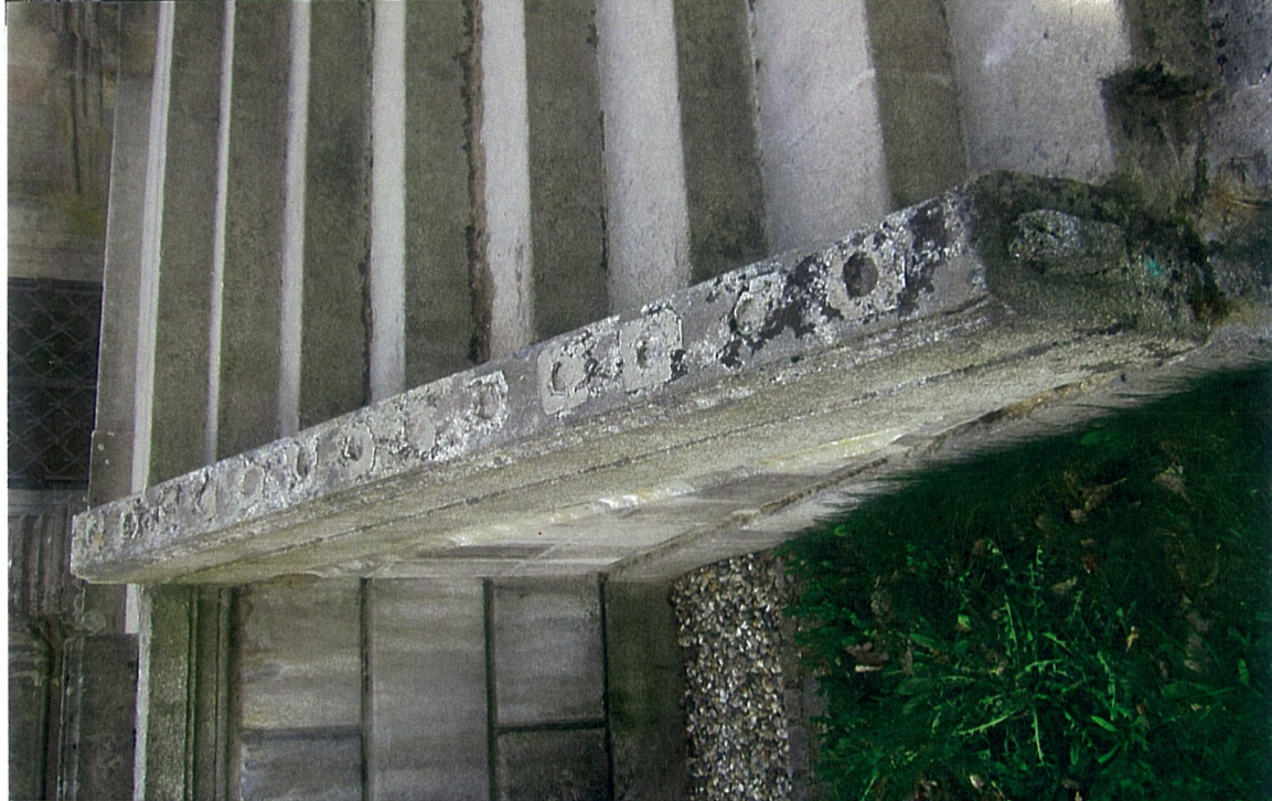
PÍSKOVCOVÁ TRNOŽ VSTUPNÍHO SCHODIŠTĚ OSAZENÁ V PRVNÍ ETAPĚ REKONSTRUKCE
