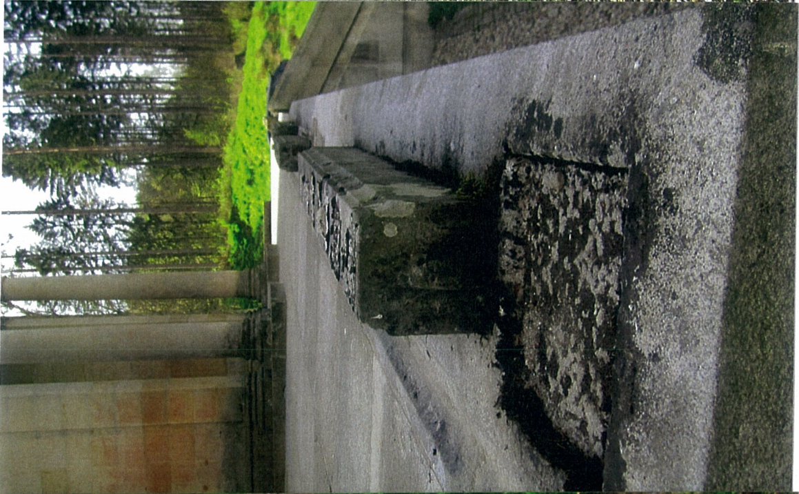
ZACHOVALÉ, PŮVODNĚ OSAZENÉ PÍSKOVCOVÉ TRNOŽE BALUSTRÁDY
