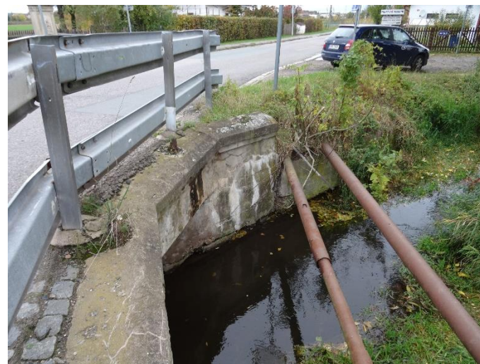
Vápenité výluhy na pravém křídle povodní strany. Vzrostlý keř.
