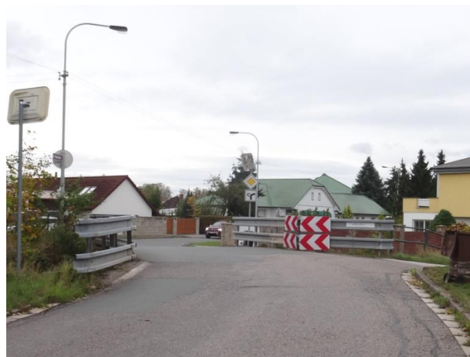
Pohled na most proti směru staničení
