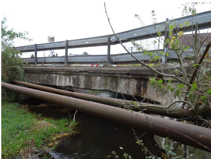
Pohled na most z návodní strany
