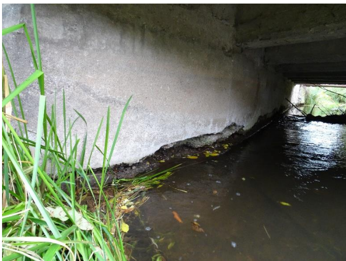
Detail podemletí podpěr v úrovni hladiny vody
