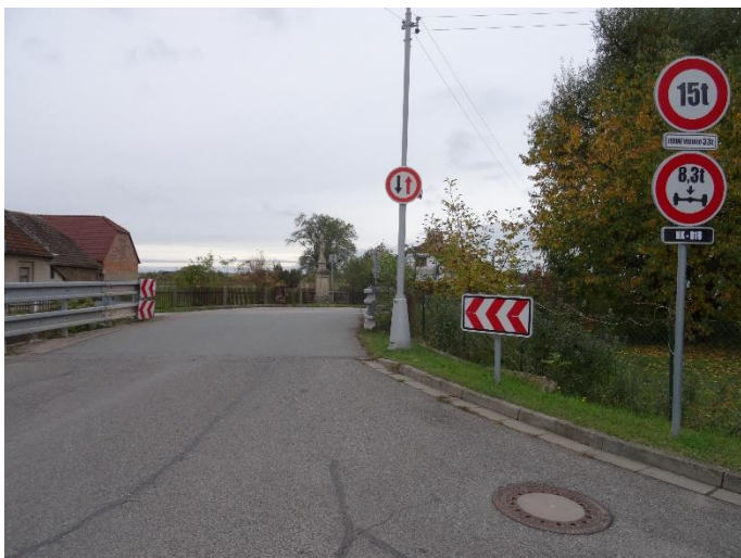
Pohled na most ve směru staničení
