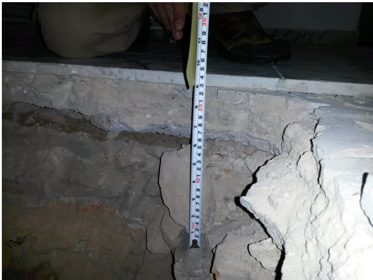
Obr. 4) Skladba odstraňované podlahy.
