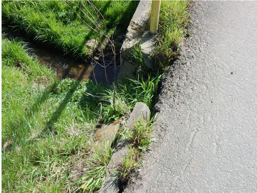
Vylomená levá krajnice komunikace včetně obrubníku
