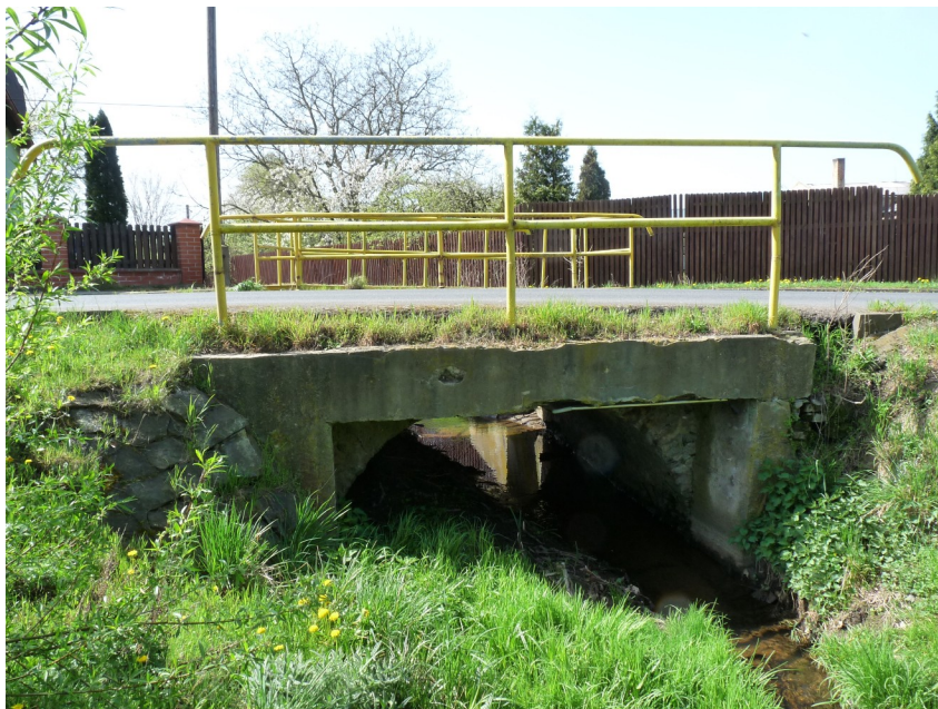
Levá strana mostu, nosná konstrukce
