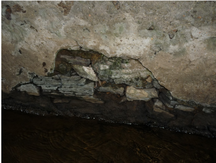
Kaverny v založení a spodní stavbě kamenné klenby
