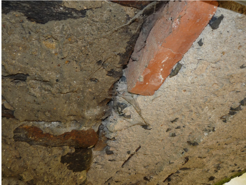
Dozdívané napojení dvou konstrukcí z různých materiálů
