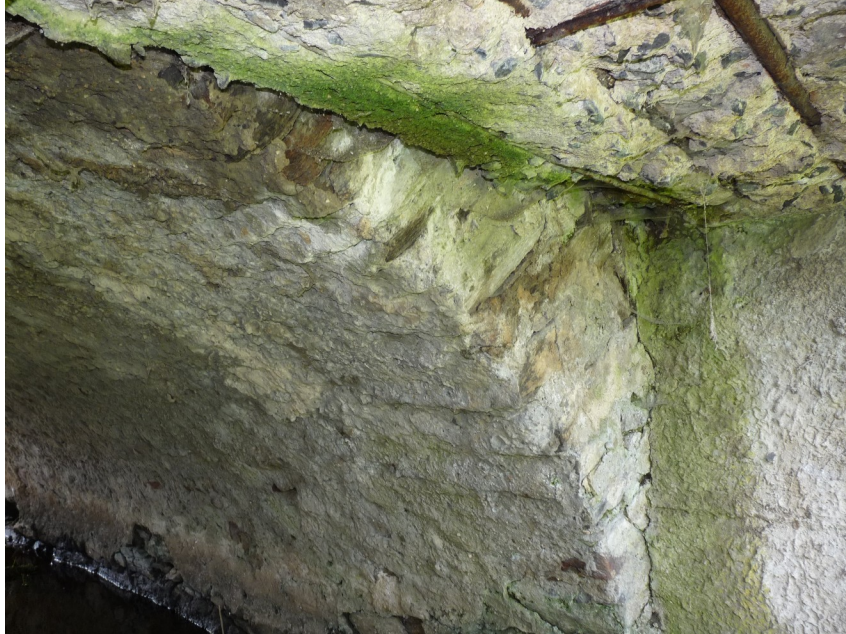
Původní kamenná segmentová klenba
