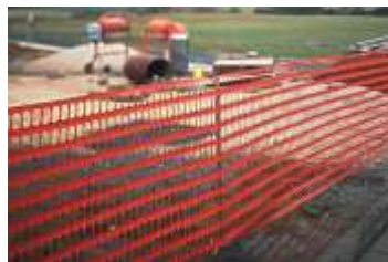
Obrázek 3 Bezpečnostní stavební plot
