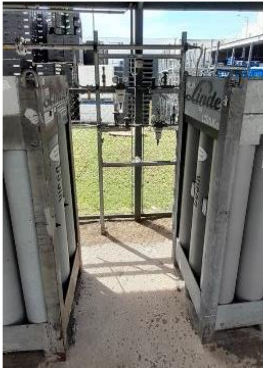
Obr. PřípojnÉ místo rozvodů dusíku na kotelně E1A
