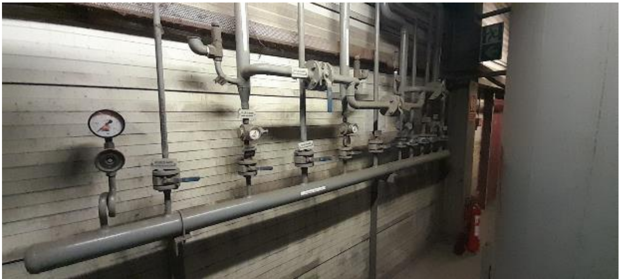
Obr. PřípojnÉ místo rozvodů dusíku na kotelně E1A
