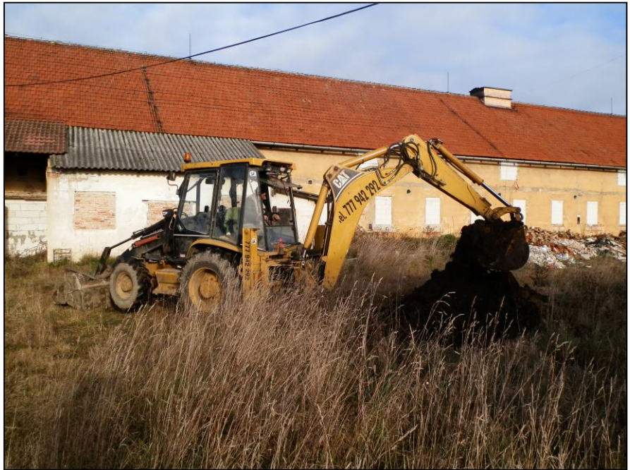
FOTO 1: hloubení sond (K5)
