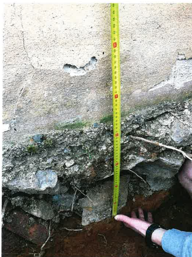
Foto č. 10 : Kopaná sonda k základům - nedostatečná hloubka založení
