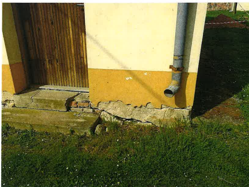
Foto č. 6 : Východní fasáda objektu - zakončení okap. svodu, opadaná omítka, praskliny
