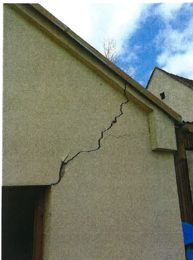
Foto č. 3 : Výrazná trhlina na fasádě u SZ nároží objektu
