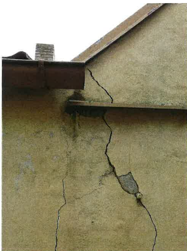
Foto č. 4 : Trhliny na styku původní a novější části
