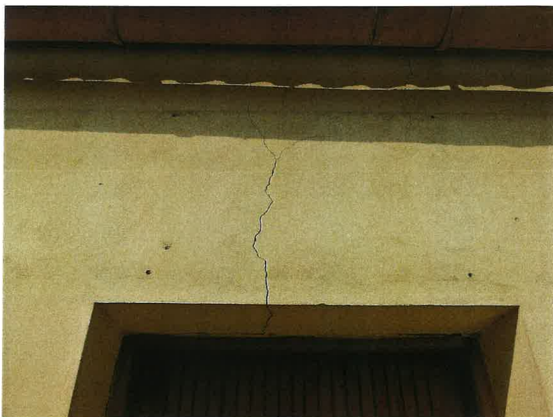
Foto č. 8 : Detail trhliny v nadpraží vstupních dveří
