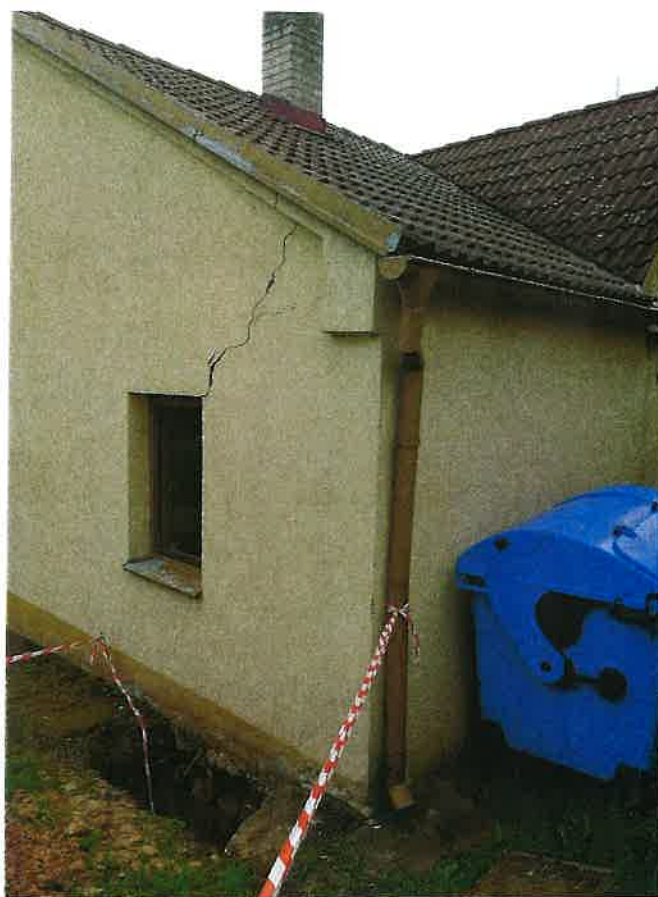
Foto č. 5 : SZ nároží objektu - kopaná sonda, trhliny na fasádě, zakončení okap. svodů
