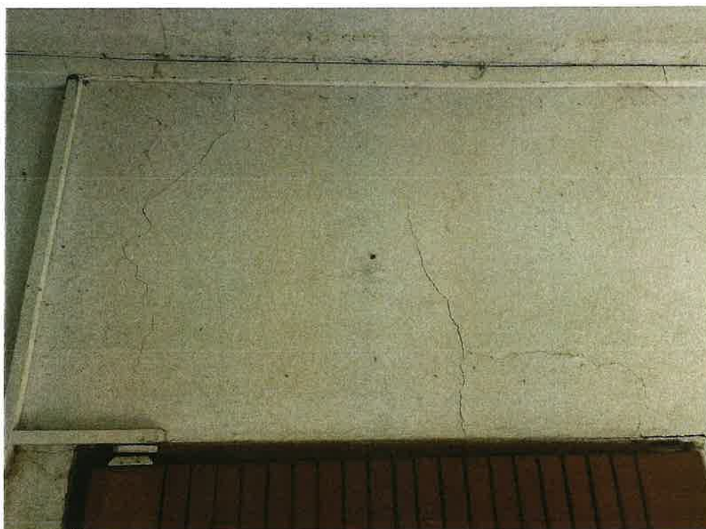
Foto č. 12 : Četné trhliny v interiéru
