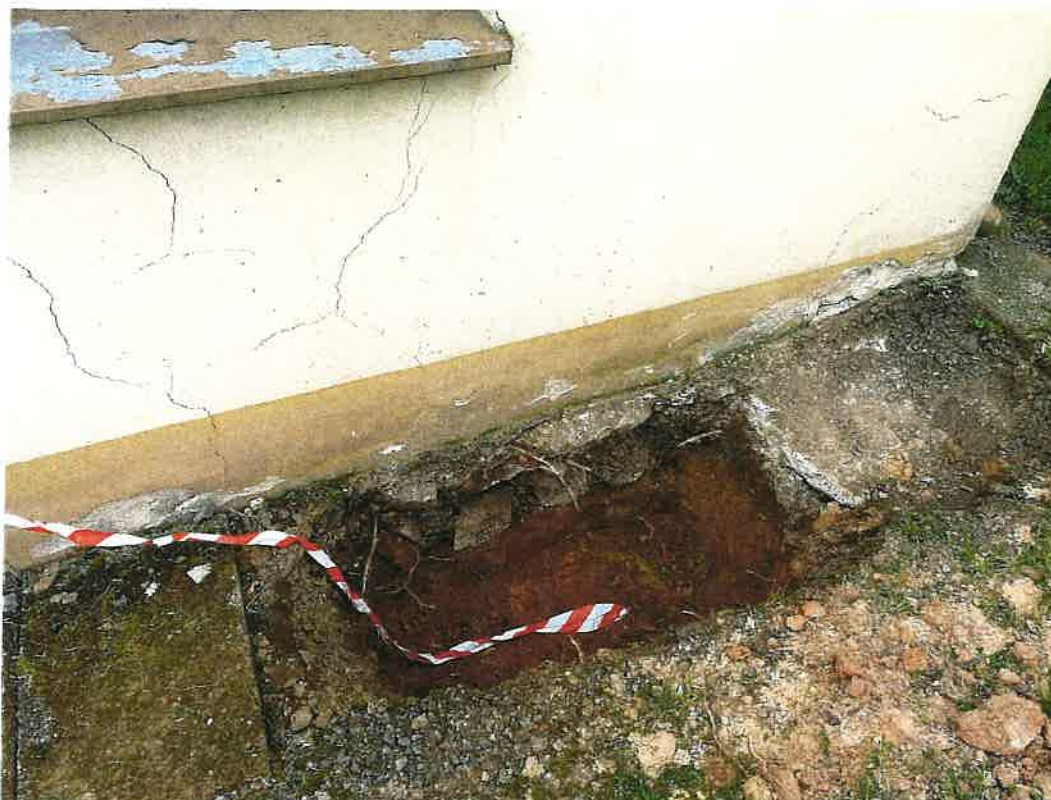
Foto č. 9 : Kopaná sonda k základům, četné trhliny na objektu
