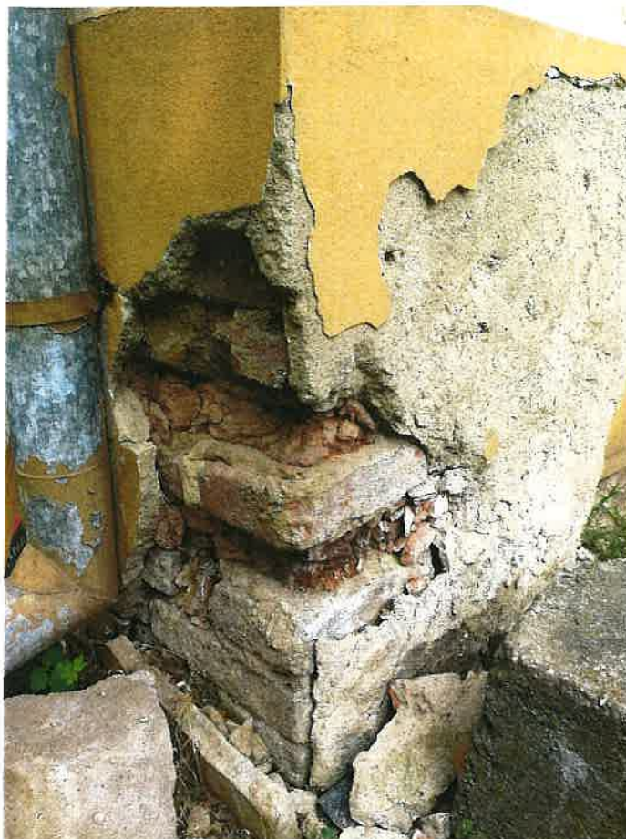
Foto č. 11 : Výrazná degradace zdiva - JV nároží
