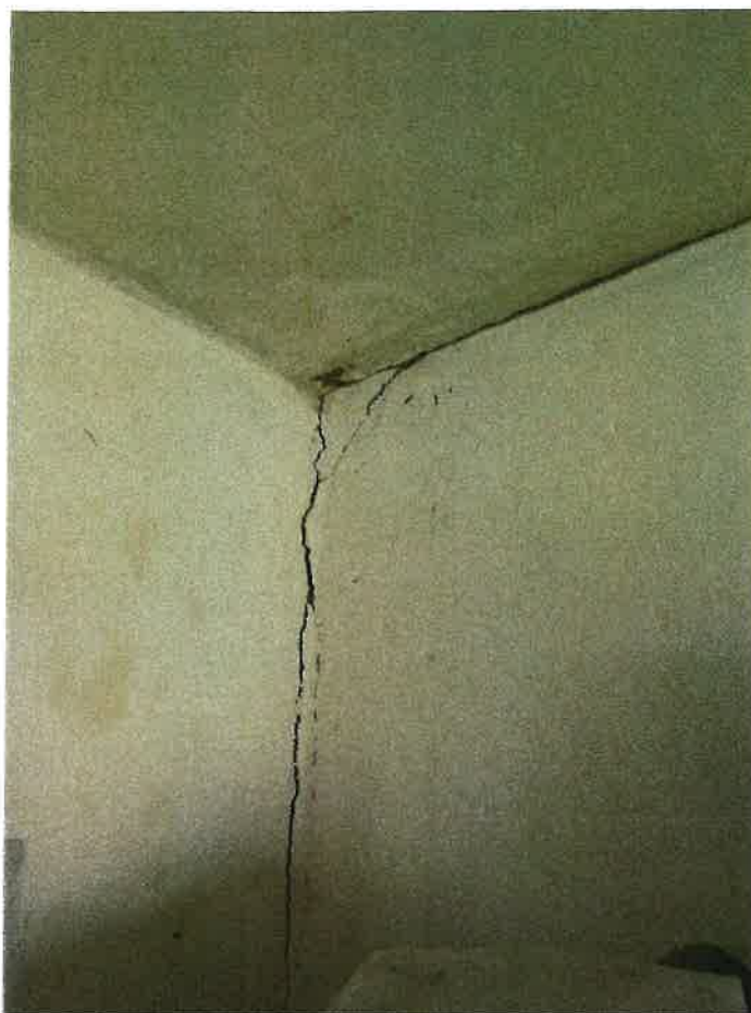
Foto č. 13 : Trhliny na styku stěn a stropu - SZ roh objektu
