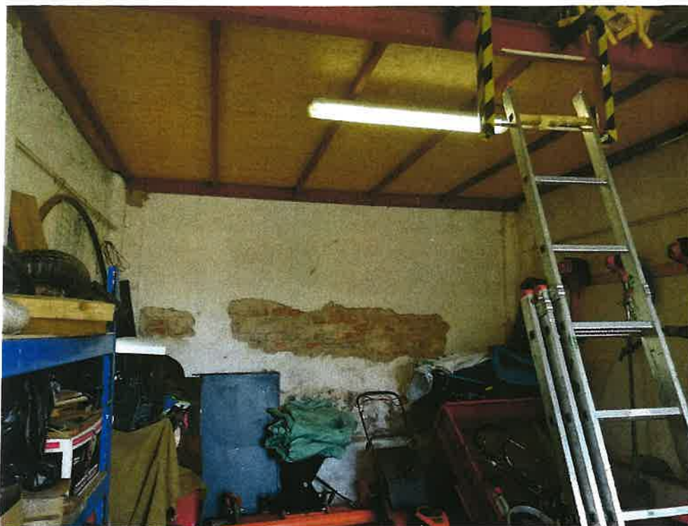
Foto č. 15 : Patrná vztlínající vlhkost v interiéru - odpadá vnitřní omítka
