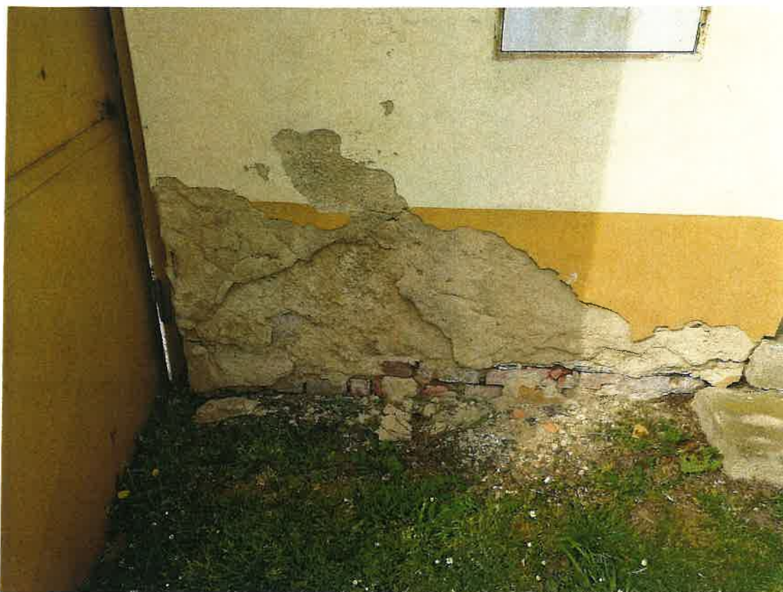
Foto č. 7 : Opadaná soklová omítka vlivem vztlínající vlhkosti
