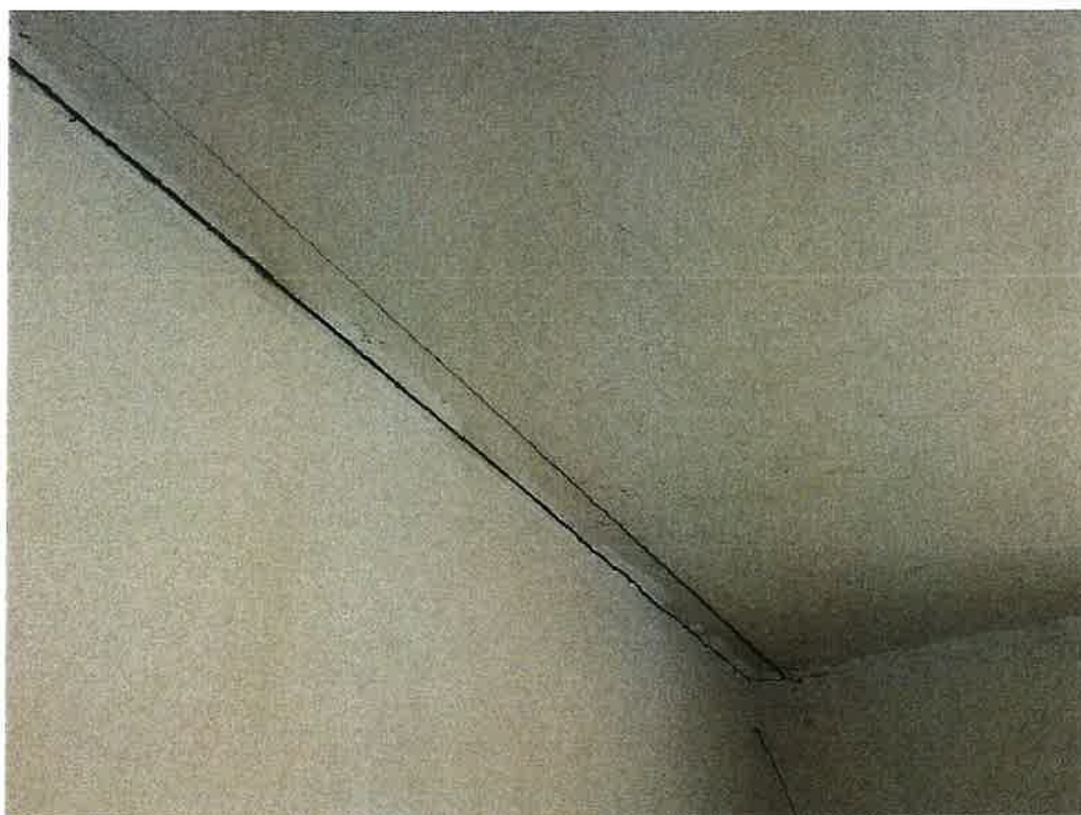
Foto č. 14 : Trhliny na kraji stropní konstrukce
