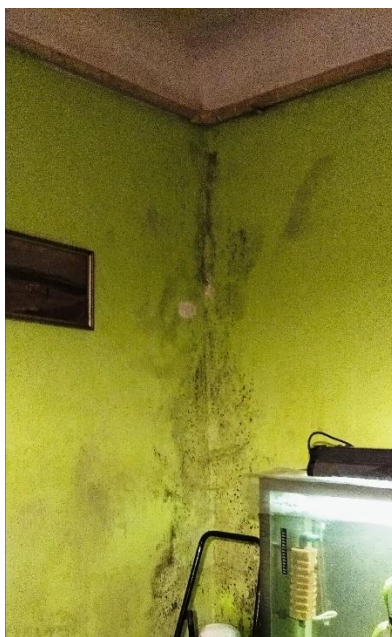
obr.2 - plísně na vnitřních nárožích místností – byt. jednotka 1.NP
