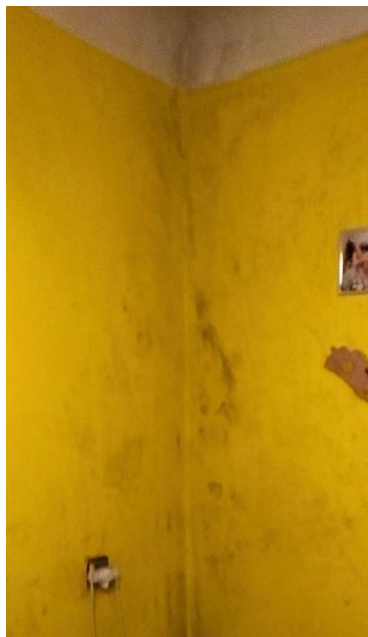
obr.2 - plísně na vnitřních nárožích místností – byt. jednotka 1.NP
