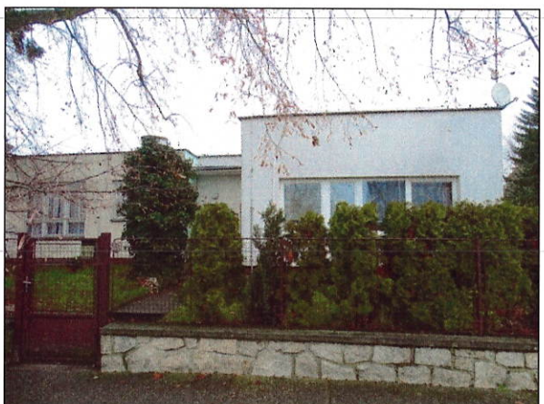
č. 15 – 16 Pavilon C, jihuozápadní průčelí
