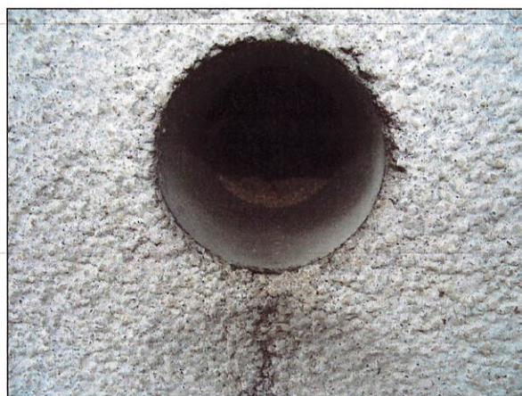
č. 21 – 22 Pavilon C, detaily VO na zatepleném severovýchodním průčelí
