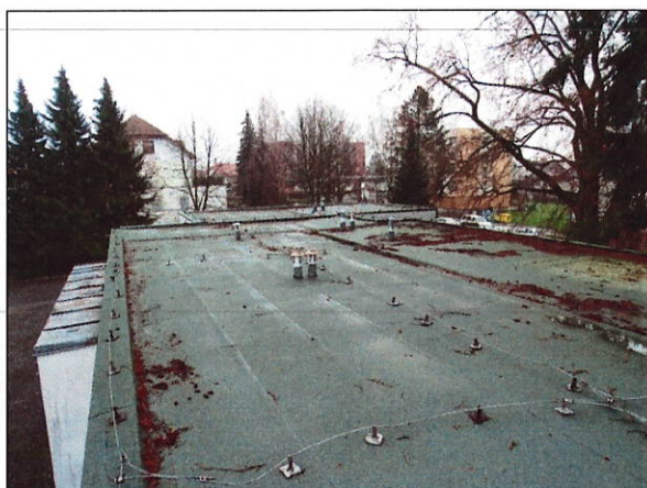
č. 20 Pavilon C, pohled na plochu střechy
