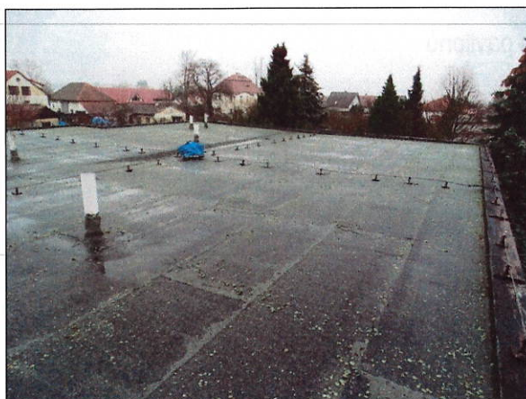
č. 8 Pavilon A, pohled na plochu střechy
