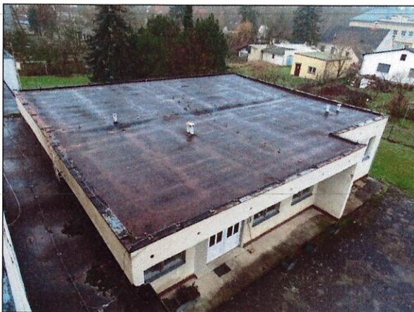
č. 14 Pavilon B, pohled na plochu střechy
