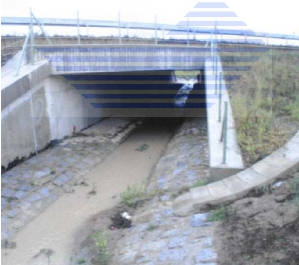
Obrázek P9 - Příklad silničního (dopravně bezpečnostního) zábradlí z ocelových lanek a sloupků z taženého kompozitního materiálu ve svahu na objektu s přesypávkou
