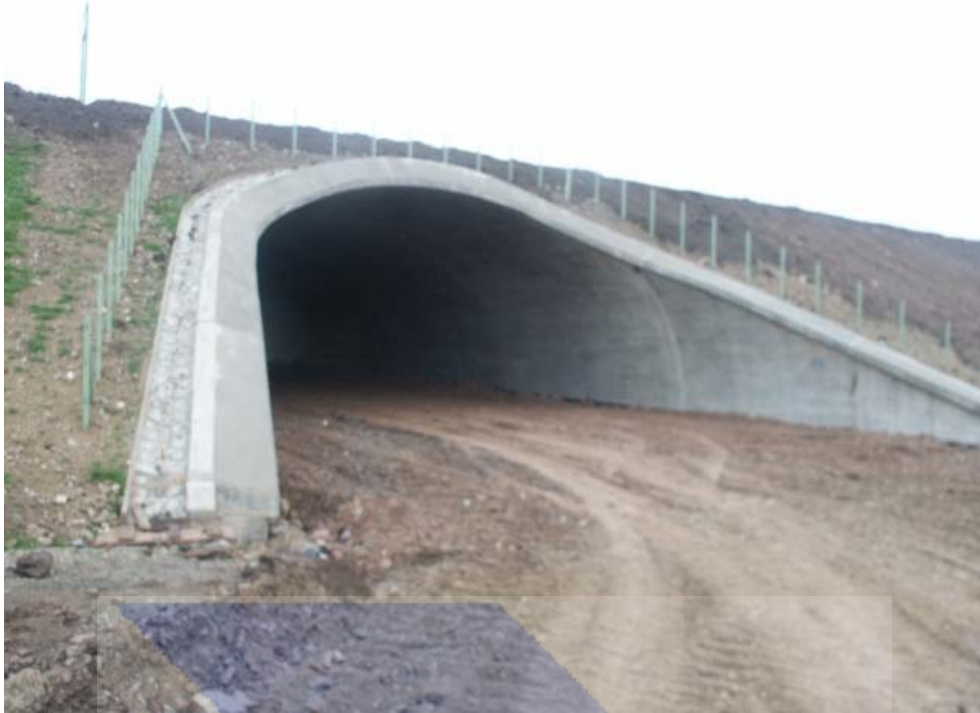
Obrázek P9 - Příklad silničního (dopravně bezpečnostního) zábradlí z ocelových lanek a sloupků z taženého kompozitního materiálu ve svahu na objektu s přesypávkou
