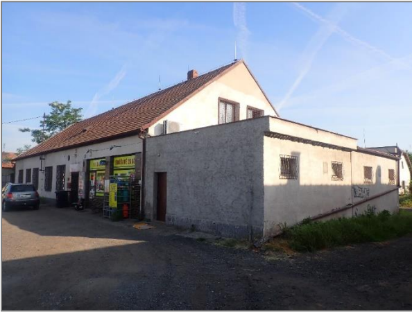
Jižní a východní část objektu č. p. 9
