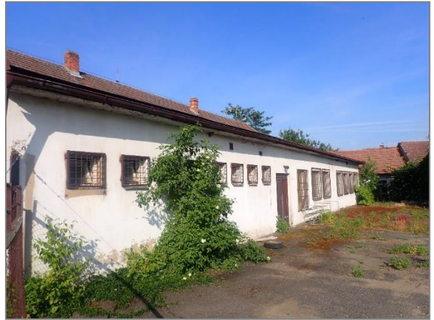
Severní přístavba k č. p. 9
