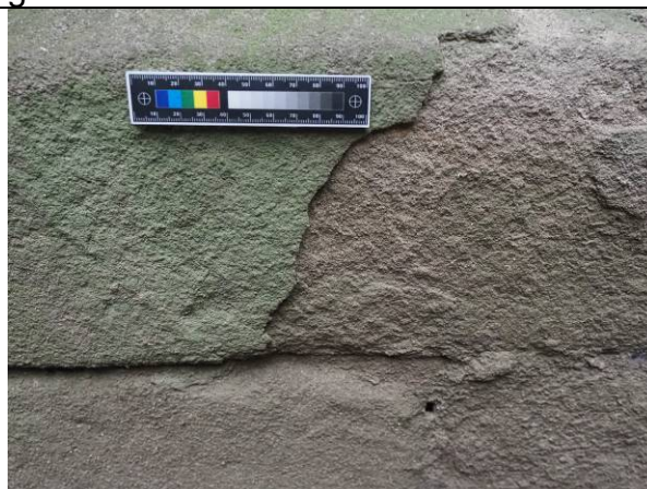
Typická degradace pískovce.
