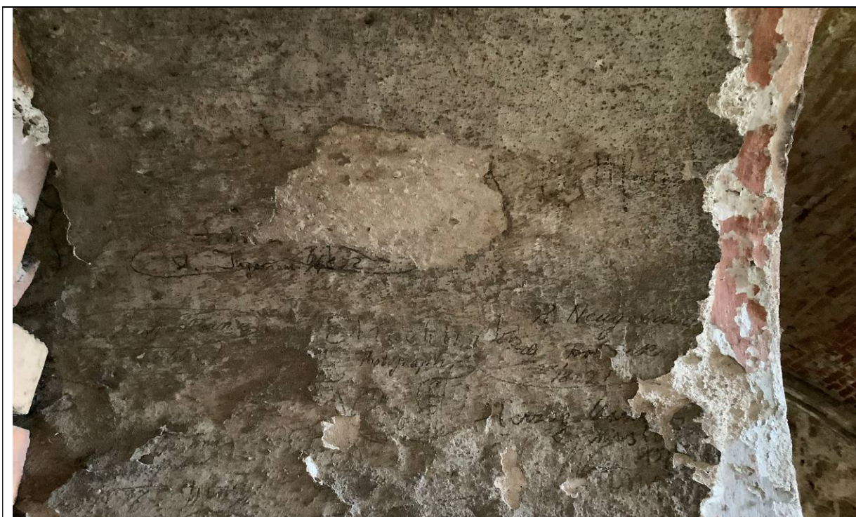
Spaleta zalděného vstupu do kaple se dvěma staršími vrstvami nástěnné malby, na poslední nejmladší omítce s nátěrem jsou cenné historické graffiti tužkou, které budou rovněž restaurovány v režimu nástěnné malby.
