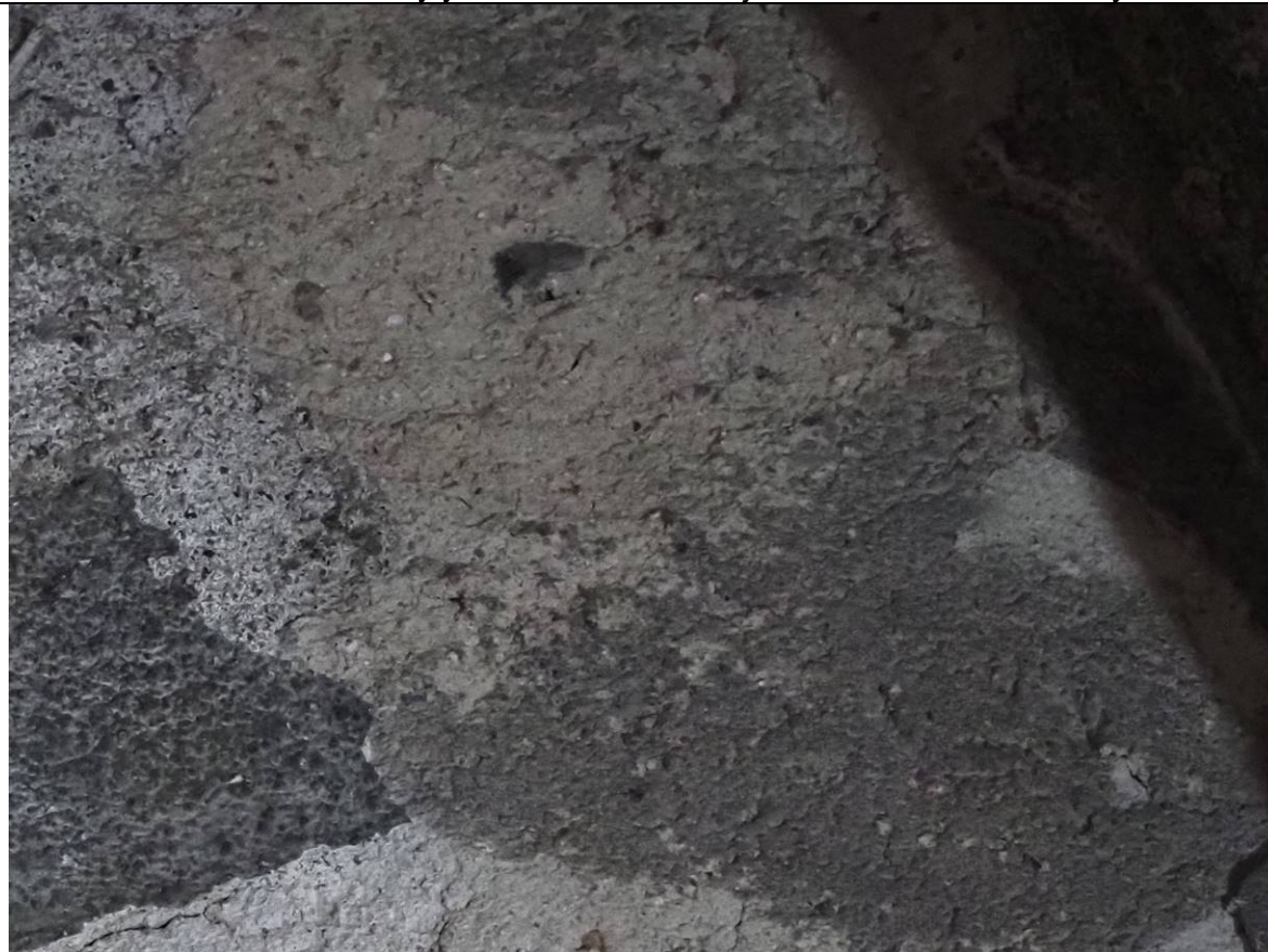
4. Jemná omítka na vrstvě s rytým kvádrováním v nejstarší části severní chodby
