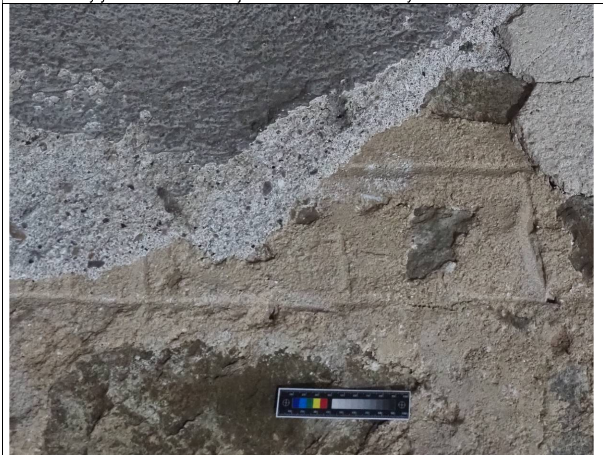
2. Omítka s rytým kvádrováním v nejstarší části severní chodby
