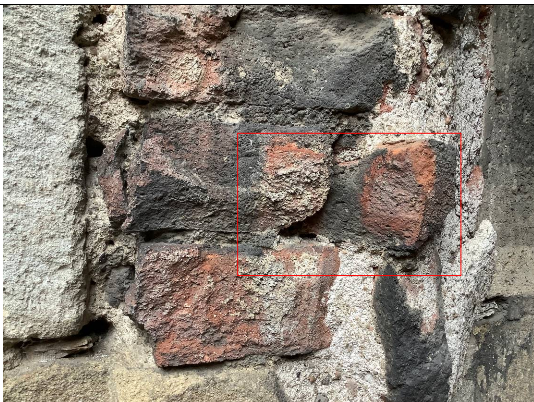
Zkouška čištění cihel laserem. Účinná a šetrná metoda. Odstraňuje tmavé krusty a depozity, ale lokálně dochází k barevné změně střepe.
