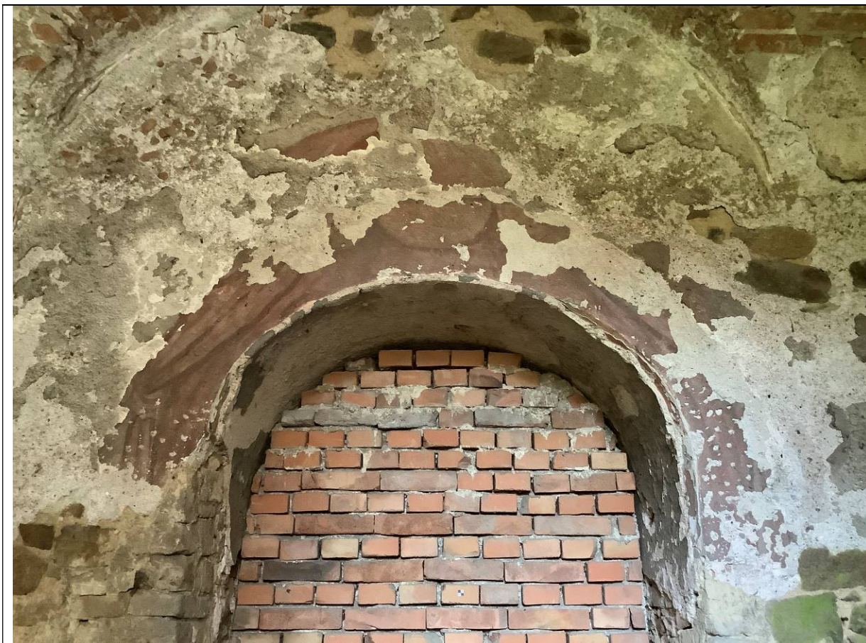
Fragmenty iluzivního malovaného baldachýnu kolem zalděného vstupu do kaple. Tyto fragmenty budou restaurovány v režimu nástěnné malby.
