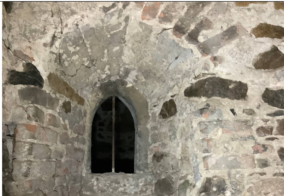
Otisk středověkého šalování v záklenku okna, patřící k cenným prvkům objektu.
