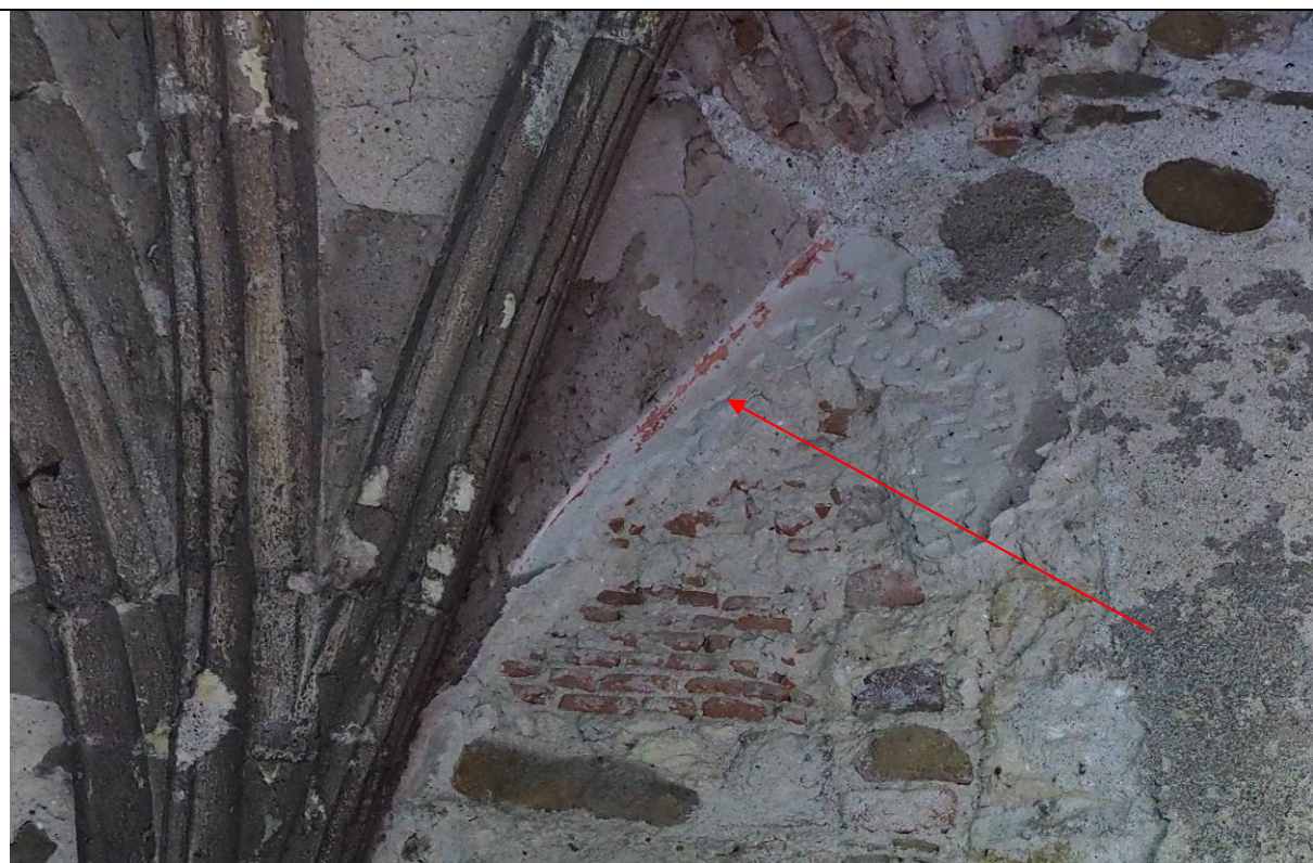
Fragment červené linky lemující klenební pole v západní chodbě 1.N.P., který bude restaurován v režimu nástěnné malby.
