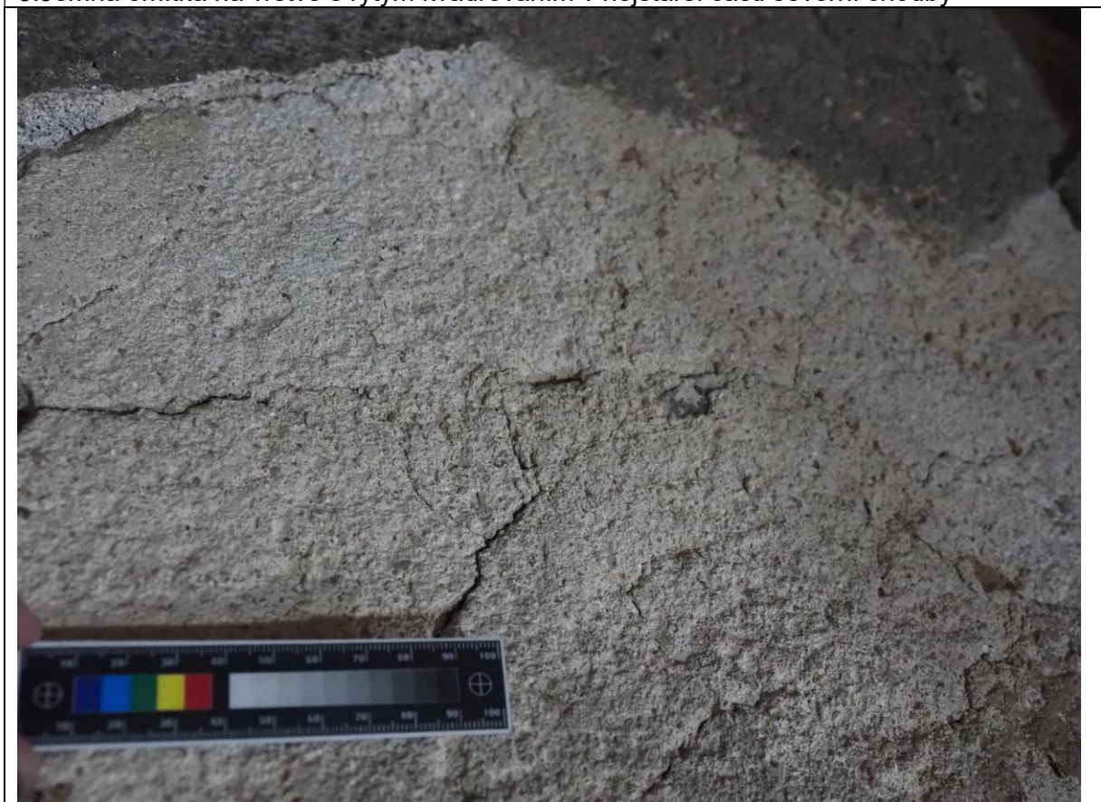
3. Jemná omítka na vrstvě s rytým kvádrováním v nejstarší části severní chodby
