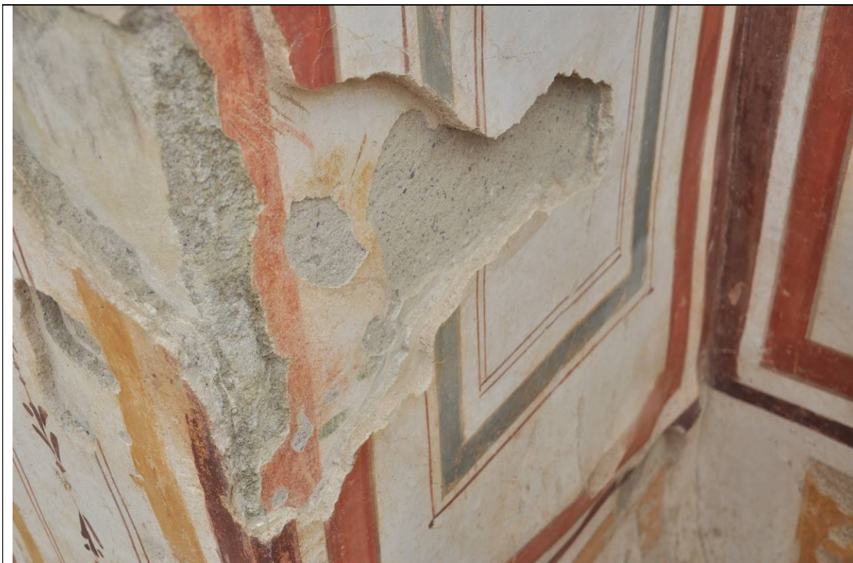
Předpokládaný způsob obtmelování jednotlivých omítkových vrstev na příkladu antických omítek v Efezu.
