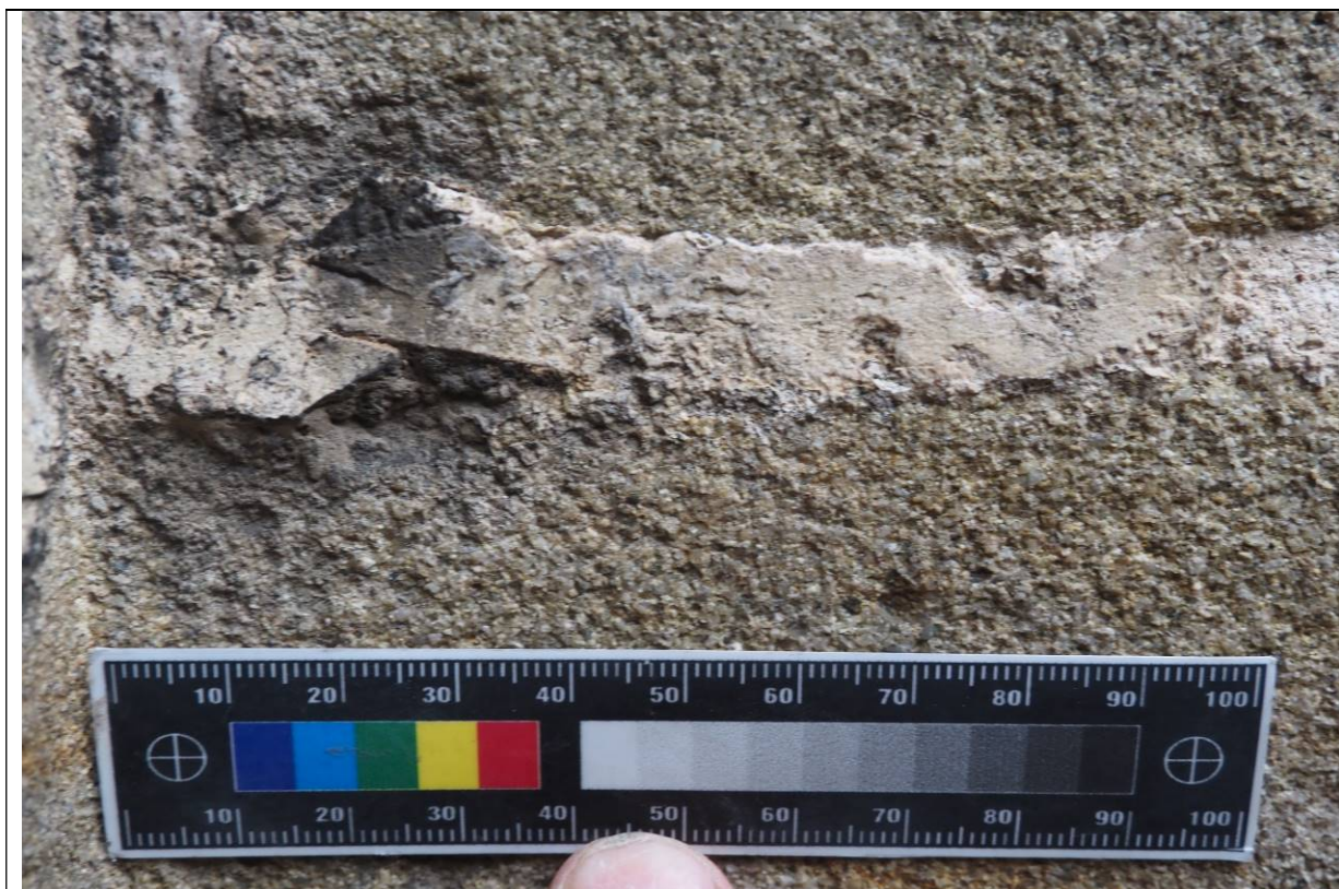
Historická spára s autentickým utaženým povrchem vápenné malty. Jedná se hodnotný prvek kterému v průběhu restaurování bude věnována zvláštní péče.
