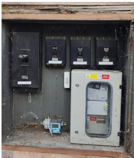
Fota stávajícího stavu: rozvaděč měření
