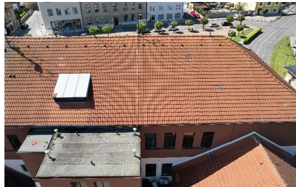
Foto č. 2 – Střecha objektu OÚ pro umístění FV
