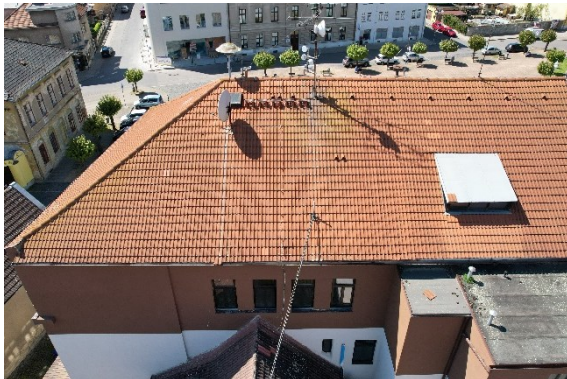
Foto č. 1 – Střecha objektu OÚ pro umístění FV
