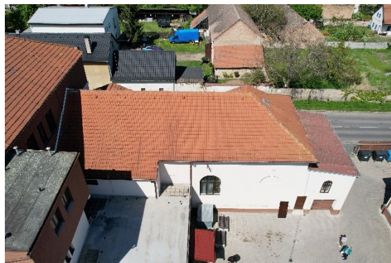
Foto č. 3 – Střecha objektu OÚ pro umístění FV
