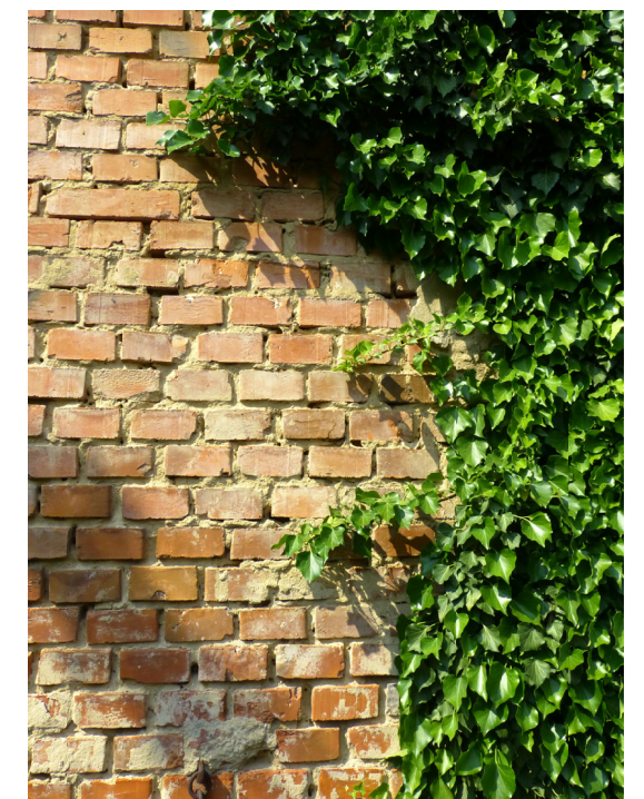
ZDIVO SOUSEDNÍHO OBJEKTU
