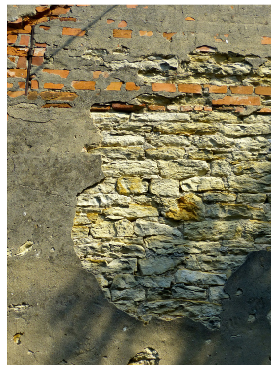
SMÍŠENÉ ZDIVO ŠTÍTOVÉ ZDI
