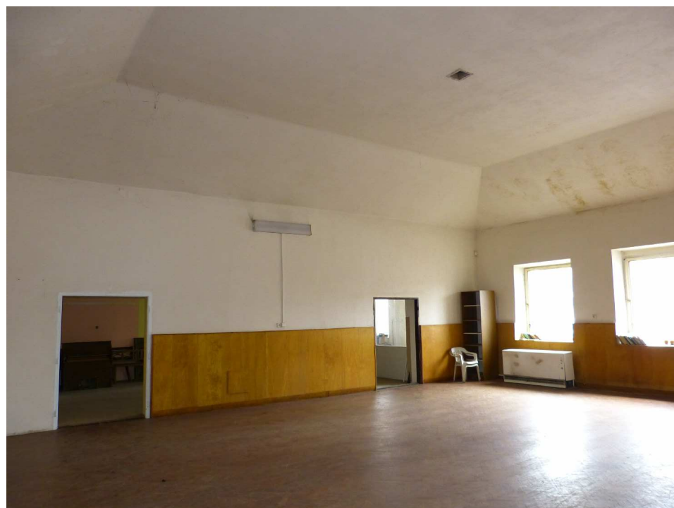
SÁL - POHLED SMĚREM K BÝVALÉ HOSPODĚ
