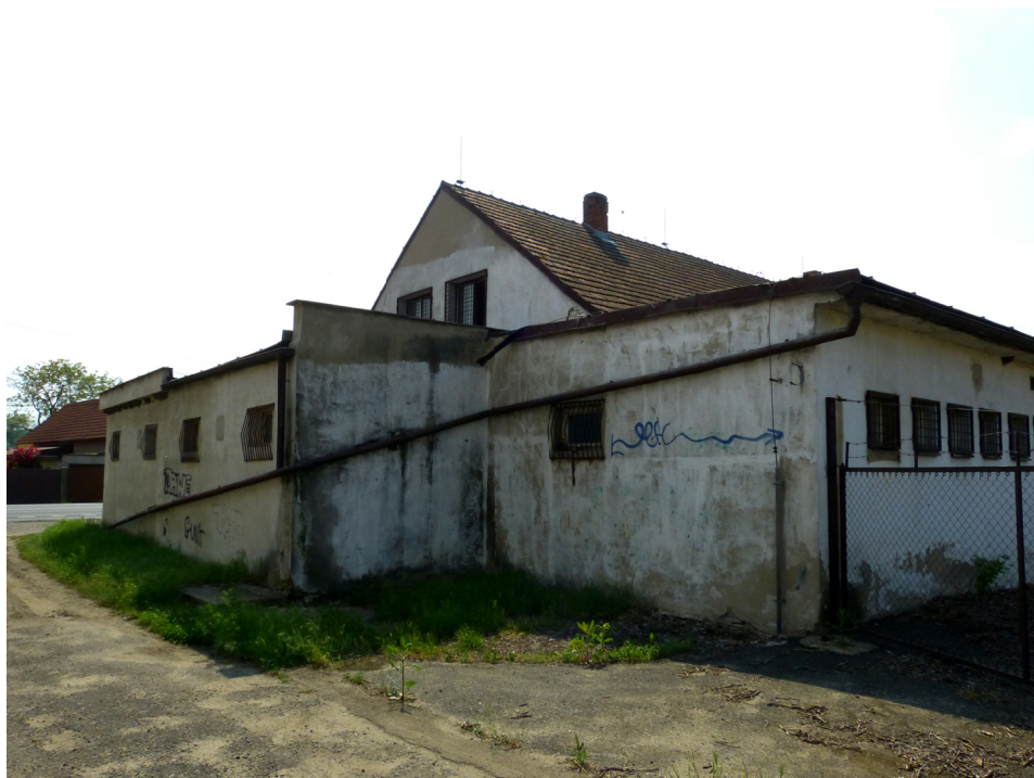
POHLED NA PŘÍSTAVBU OD VÝCHODU
