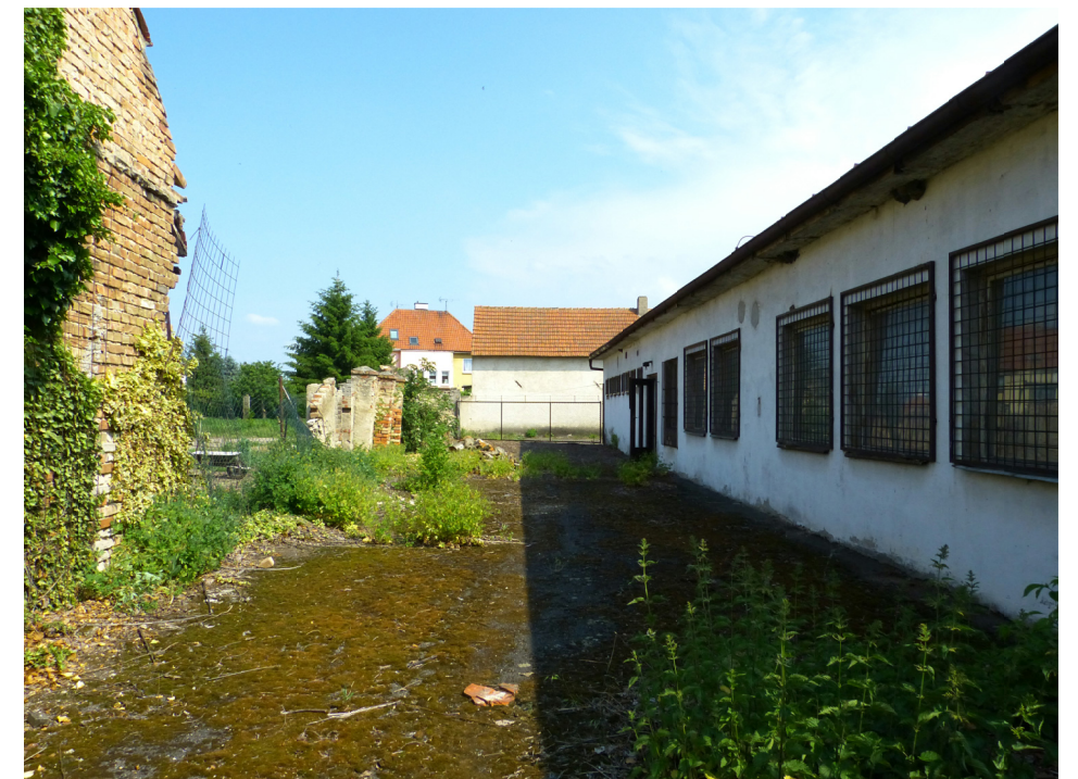
ZADNÍ ČÁST POZEMKU - POHLED OD SEVEROZÁPADU
