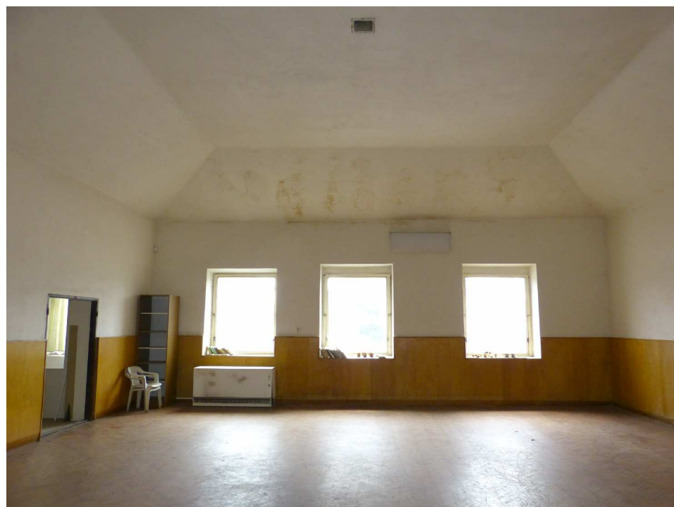
SÁL - POHLED NA OKNA V HLAVNÍM PRŮČELÍ
