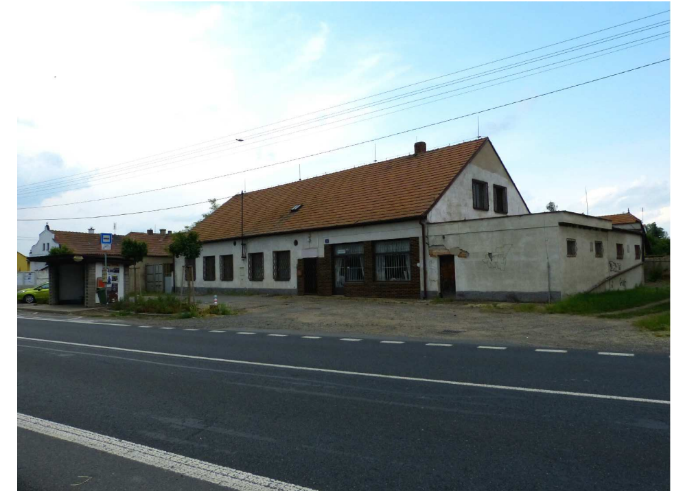
POHLED OD JIHU
