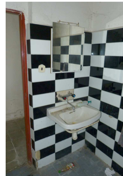
BÝVALÁ UMÝVÁRNA A WC
