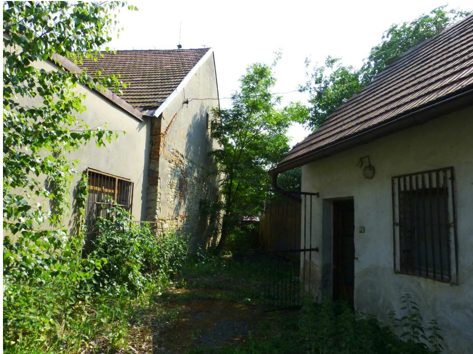
HLAVNÍ BUDOVA, SOUČASNÁ PŘÍSTAVBA A SKLAD
