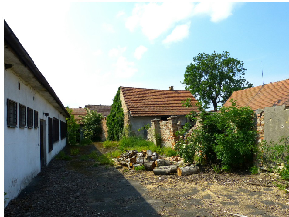
ZADNÍ ČÁST POZEMKU - POHLED OD SEVEROVÝCHODU
