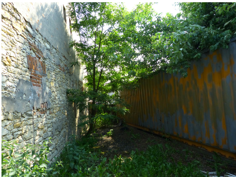
PROSTOR MEZI HLAVNÍ BUDOVOU A KONTEJNEREM
