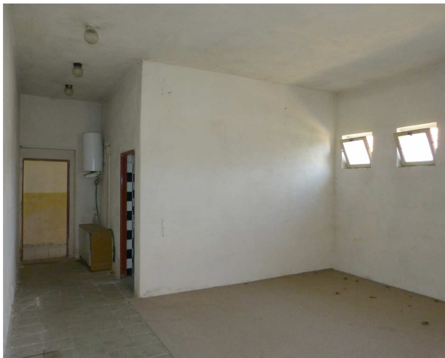
INTERIÉR SOUČASNÉ PŘÍSTAVBY
