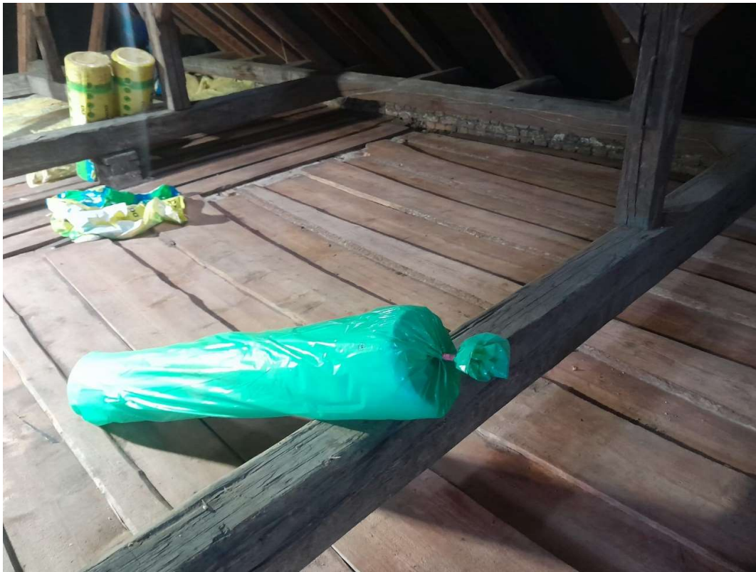
Foto trémového stropu s horním a dolním záklopem
