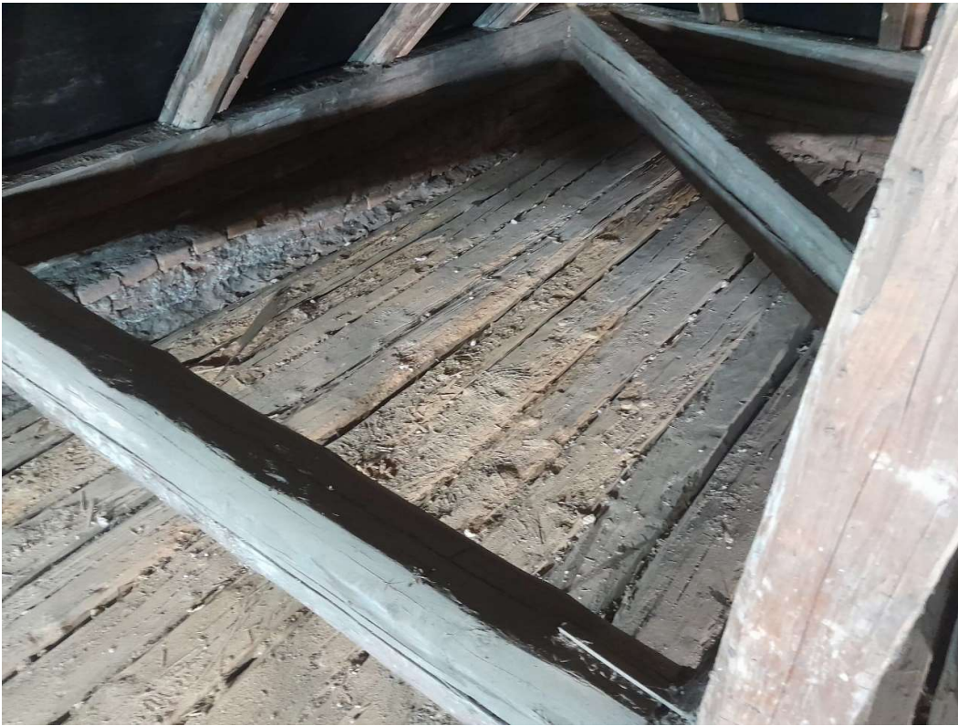
Foto povalového stropu (předpokládána demontáž a nahrazení zatepleným podhledem)
