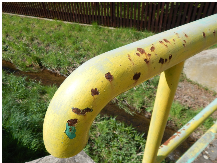
Koroze zábradlí
