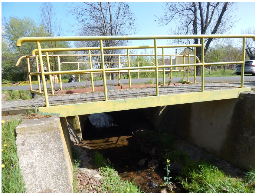
Nosná konstrukce lávky
