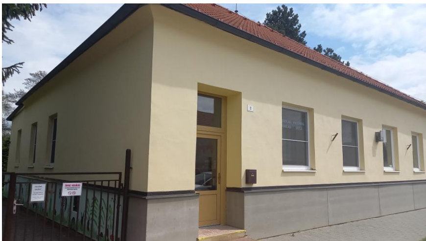
Foto č. 1 – Objekt pro umístění FVE.
