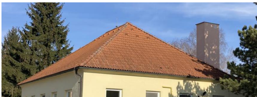
Foto č. 2 – Střecha objektu pro umístění FVE – jižní a východní.
