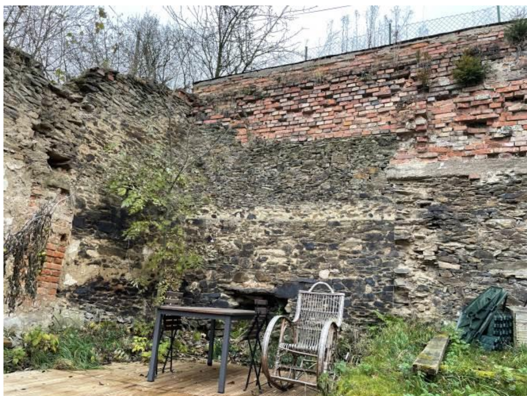
Obr. 10 Pohled na stěnu ze zahrady objektu č.p. 47
